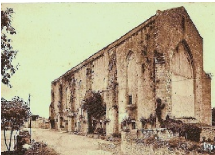
La chapelle des Cordeliers, en piteux état avant les effondrements de 1961 et 1962.
